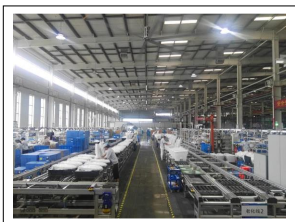
图 3 车间冷水机空调
